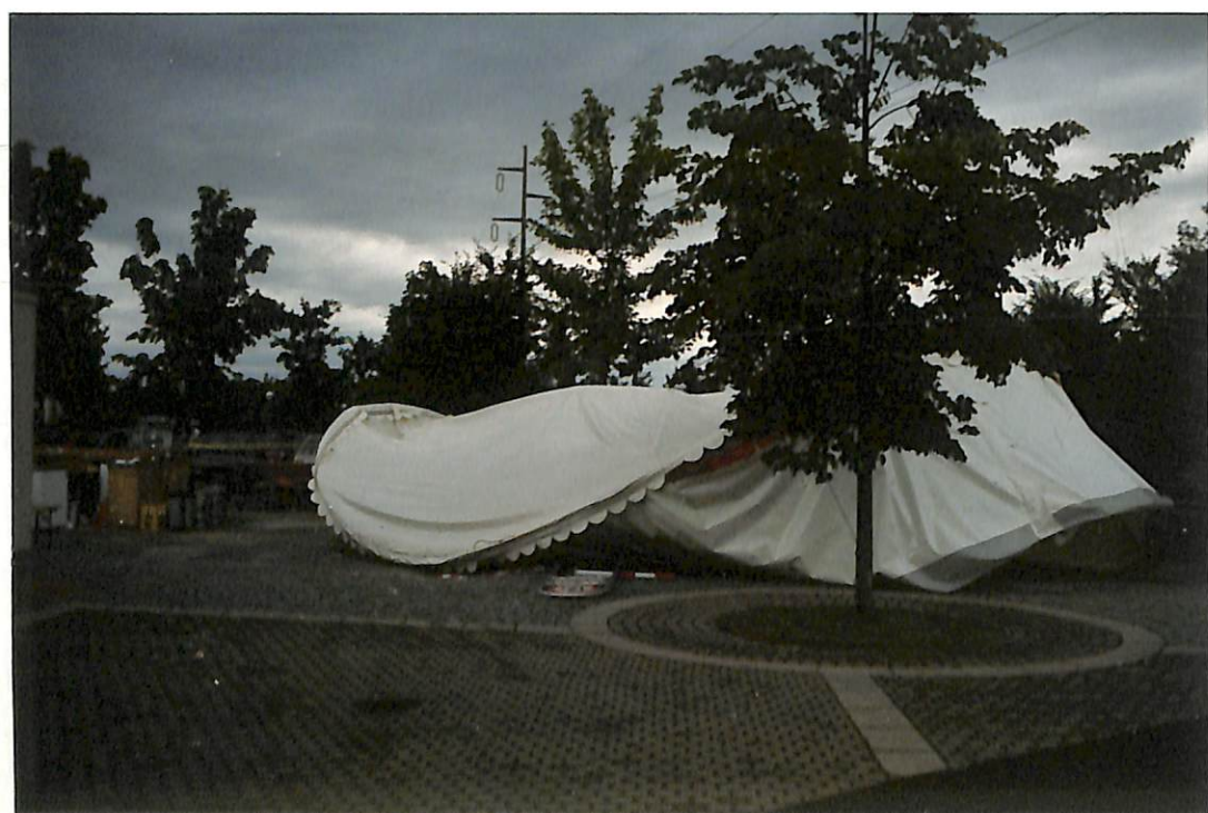
Das vom Sturm zerlegte "Fit-Zelt"
